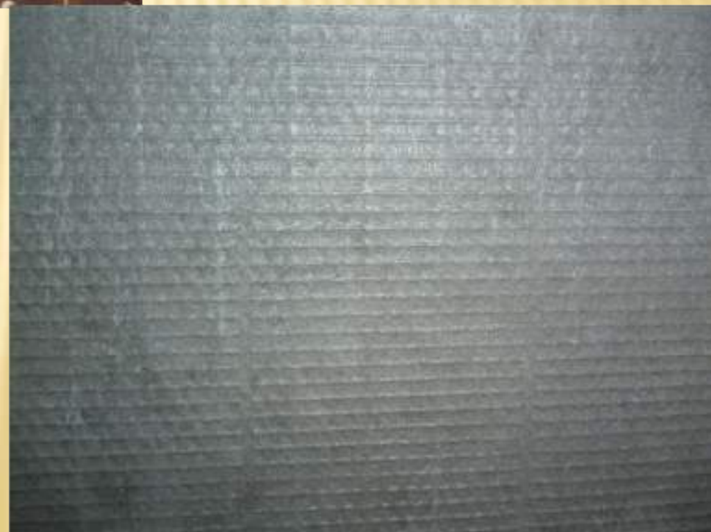
型枠脱型後 (タイル下地用)
