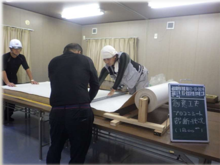
裁断口スを無くすため製作台を設置
