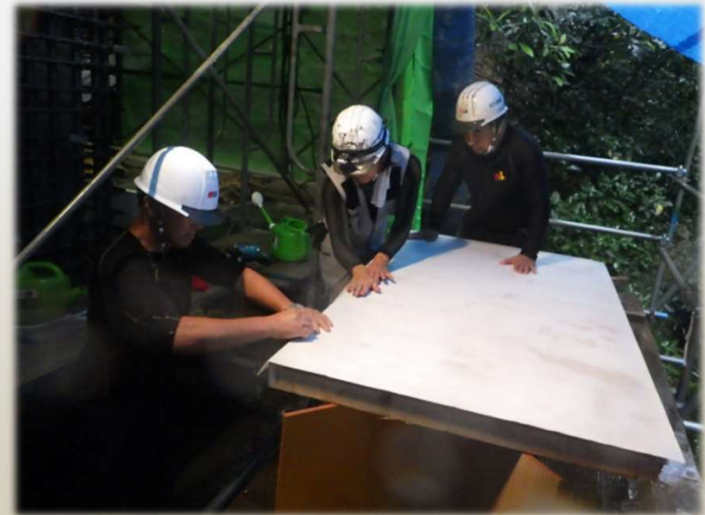
現場でしわにならないよう貼付け
