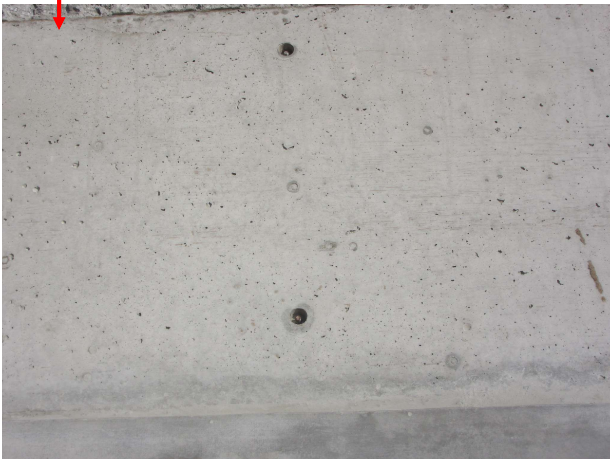
従来型枠のコンクリート表層仕上面
