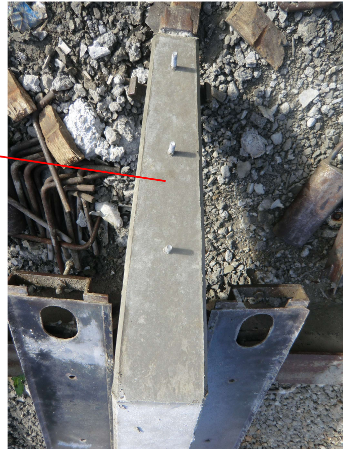
プロコンシート 一般用 使用 ピンホールなし （室外にて常温打設）
